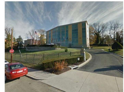
5. 1025 MICHIGAN AVE NE
