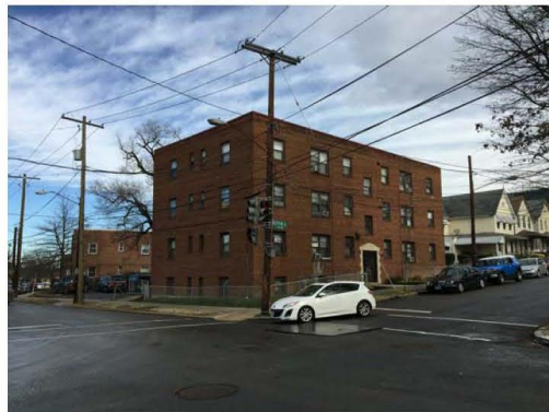
2. 1000 OTIS ST NE
